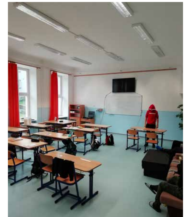
Učebna D3 po rekonstrukci
