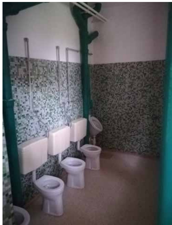
Původní stav WC dětí 1. NP
