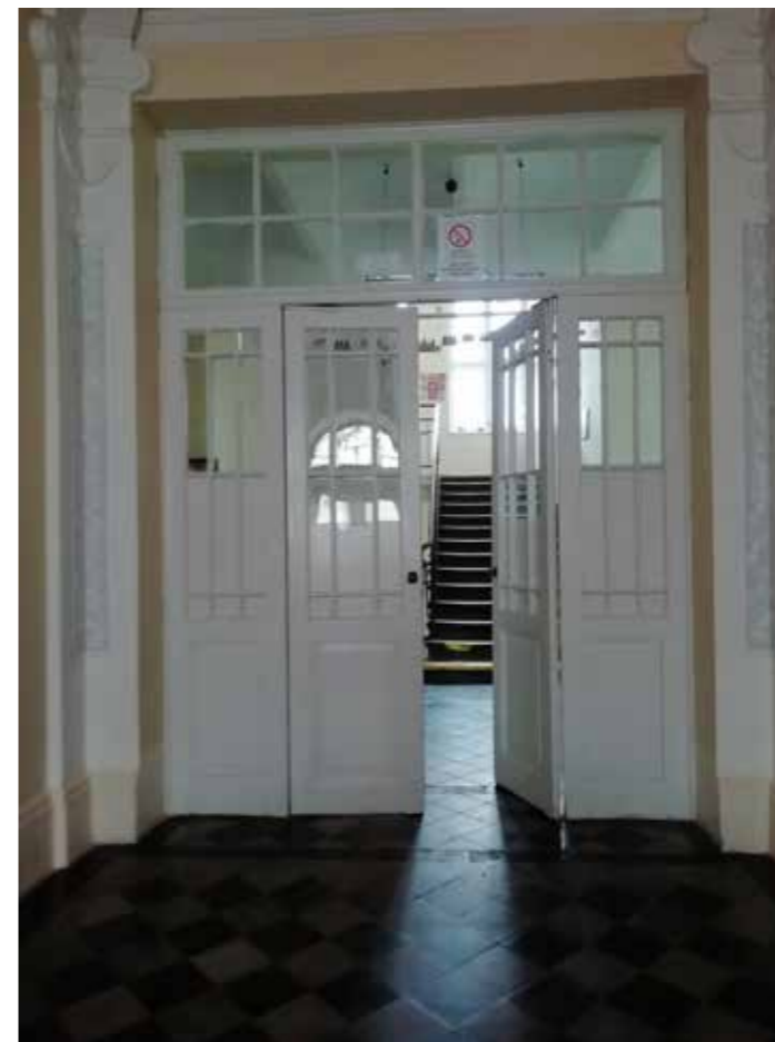
Dveře z vestibulu na chodbu původní
